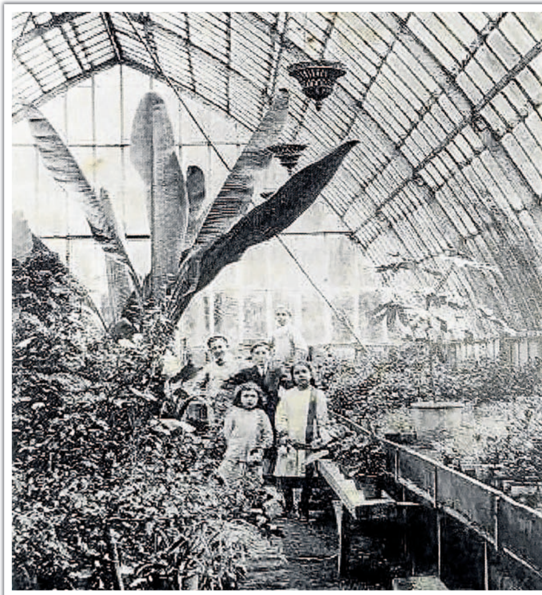
Vista del interior del invernadero de La Florida hacia 1910. :: ARCHIVO MUNICIPAL
